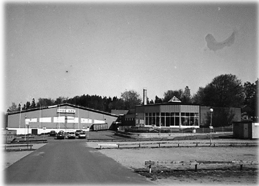
Tyrs Hovs idrottsanläggning
